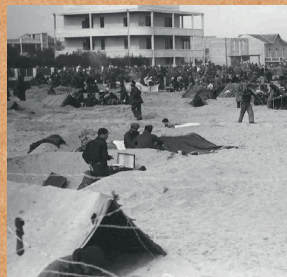
Vista interior del camp d'Argelers, 1939
