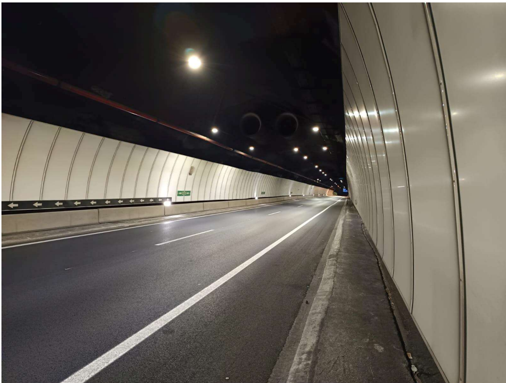
Un dels dos tubs del túnel de Parpers, a la C-60
