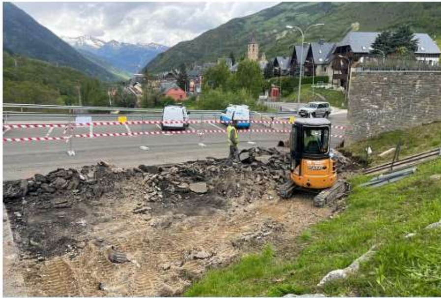
Obres aquest any a Naut Aran per desplegar un sistema de 'district heating'. - AJUNTAMENT DE NAUT ARAN
